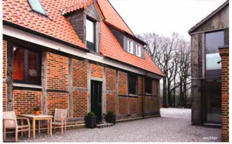
Das sanierte Fachwerk strahlt in neuem Glanz. Für viel Licht im Inneren des Hauses sorgen die neu geschaffene Tür sowie zusätzliche Fenster und Giebeln.
