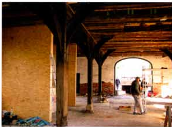
Sechs alte Eichenständer und der Aufgang nach oben über die alte Heubodenluke waren die Gegebenheiten, die das Architekturbüro PLAN WZK geschickt in ein offenes, modernes Wohnkonzept integrierte.
