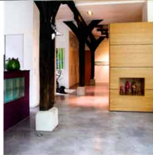
Sechs alte Eichenständer und der Aufgang nach oben über die alte Heubodenluke waren die Gegebenheiten, die das Architekturbüro PLAN WZK geschickt in ein offenes, modernes Wohnkonzept integrierte.
