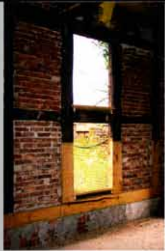
Mit großer Sorgfalt und Sachkenntnis sanierte das Bauunternehmen HERBERT das Fachwerk.
